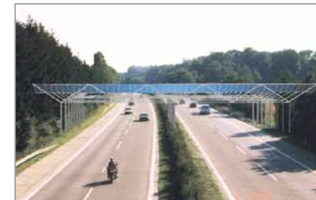
PV-Solkraftwerk über der Autobahn
