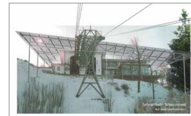
PV-Überdachung der Solarseilbahn Schauinsland
