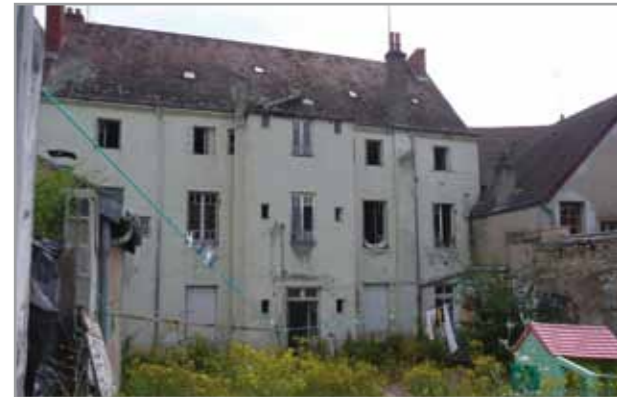
Paray-le-Monial vor der Sanierung
