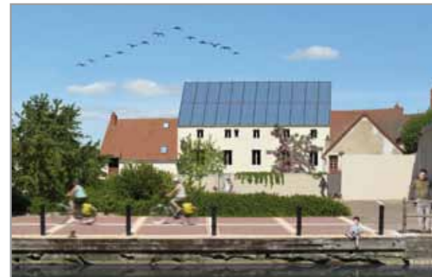
Paray-le-Monial nach der Sanierung
