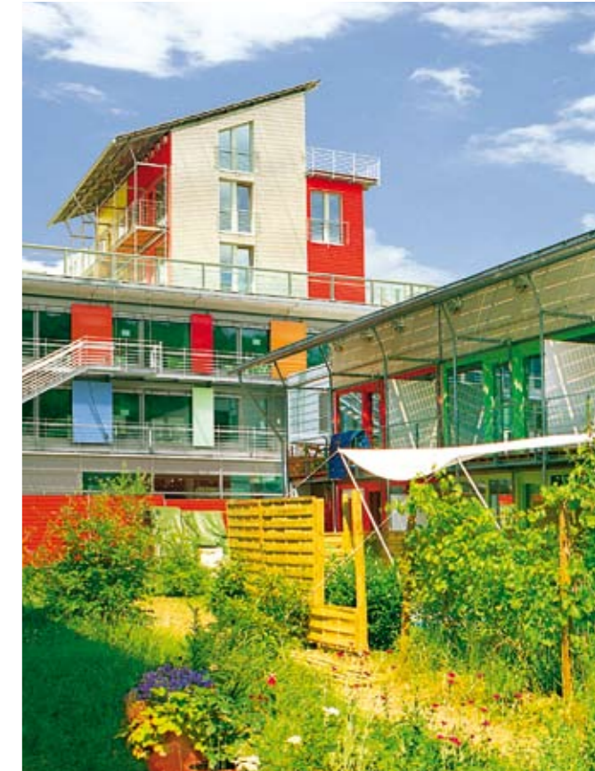
Solarsiedlung Freiburg, Blick auf ein Penthaus
