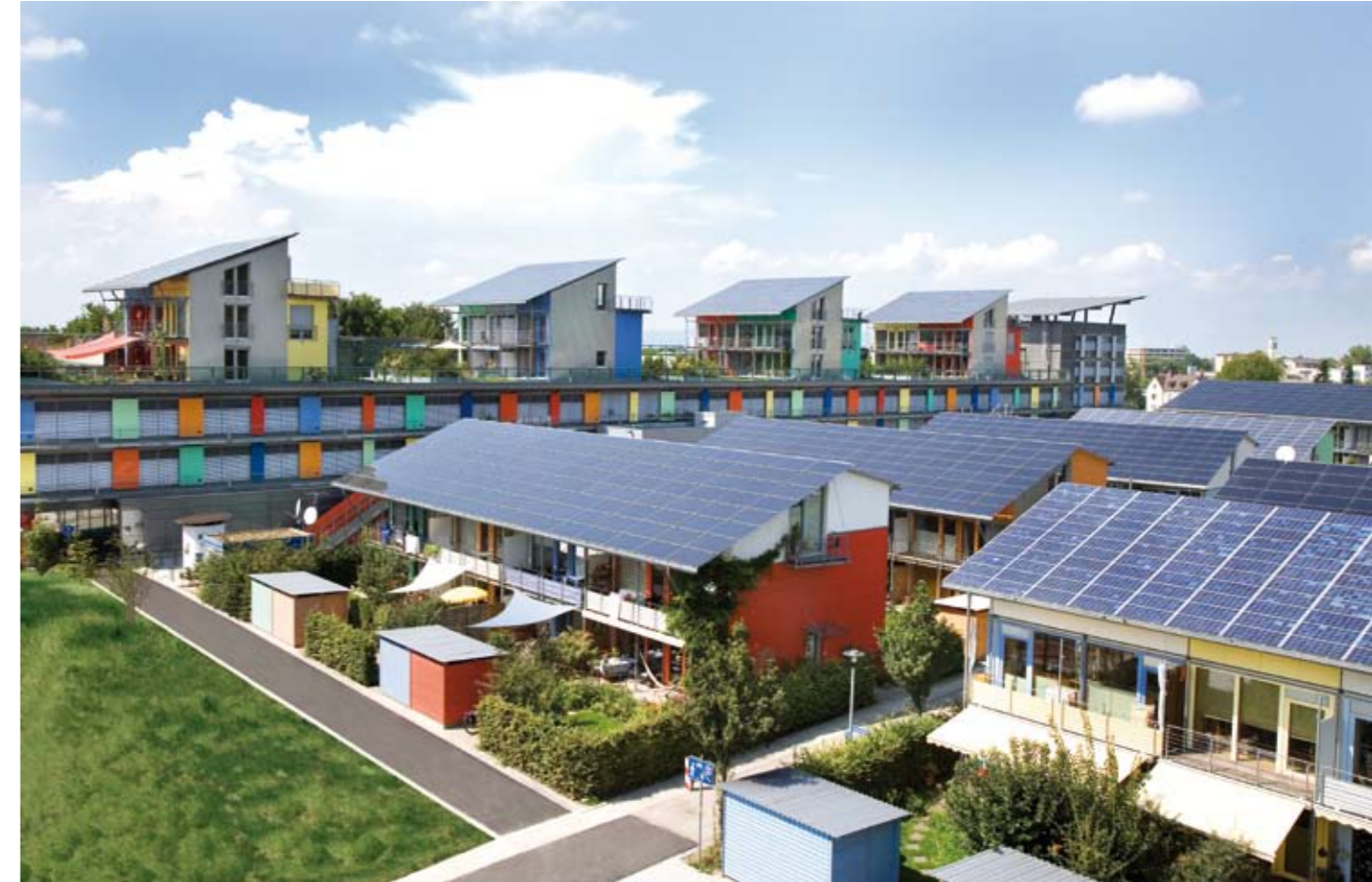
Die Solarsiedlung in Freiburg, im Hintergrund: das Sonnenschiff mit Plusenergie-Penthäusern
