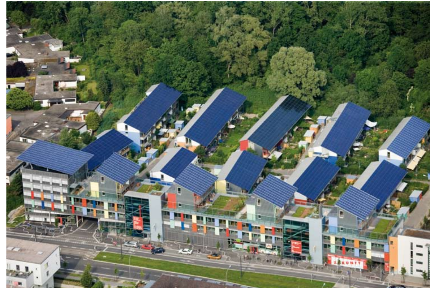
Die Solarsiedlung in Freiburg, im Vordergrund: das Sonnenschiff
