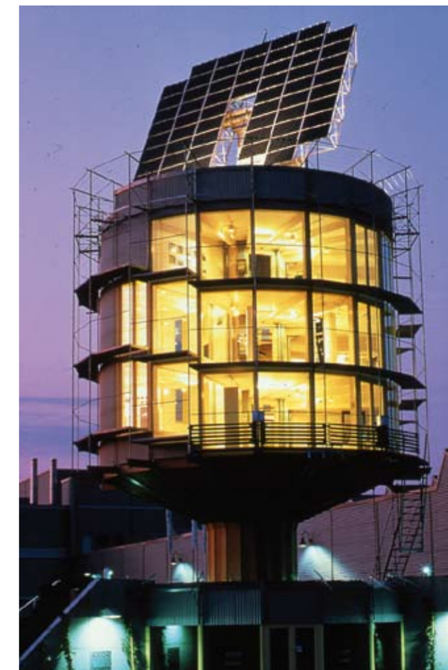
Solarturm der Firma hansgrohe in Offenburg
