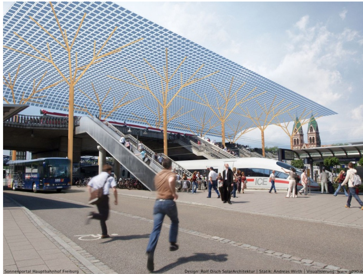
Sonnenportal Hauptbahnhof Freiburg
