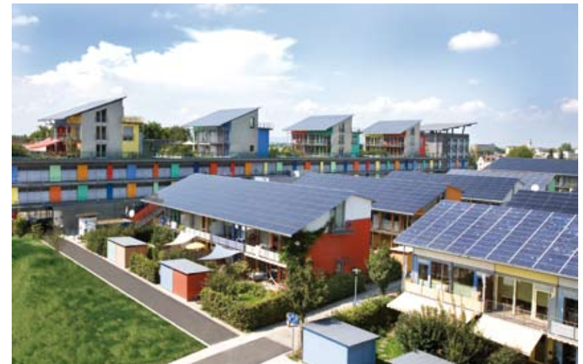
Die Solarsiedlung in Freiburg – im Hintergrund das Sonnenschiff mit Penthäusern auf dem Dach
