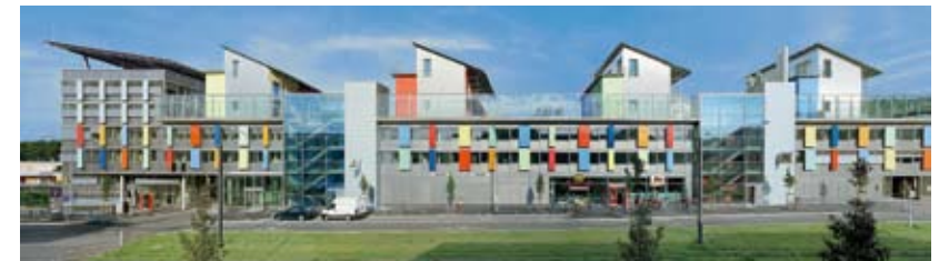
Das Dienstleistungsgebäude „Sonnenschiff“ in Freiburg - mit neun Penthäusern auf dem Dach
